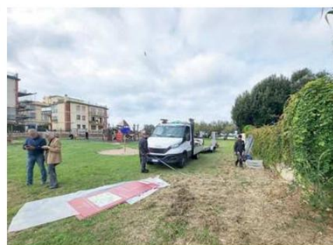
I lavori partiti ieri al parco Lenci, adiacente al Puini Ceron (Banditella) per la realizzazione di aree inclusive: cantiere di quattro mesi
